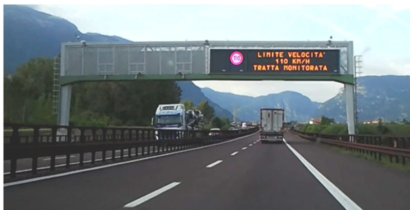
Figura 12: Limite di velocità esposto sui pannelli a messaggio variabile con associato il messaggio “tratta monitorata” sui PMV.
