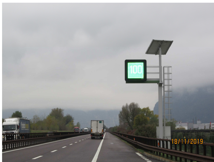
Figura 5: PMV fotovoltaico utilizzato per esporre il pittogramma di velocità consigliata durante le sessioni di test.
