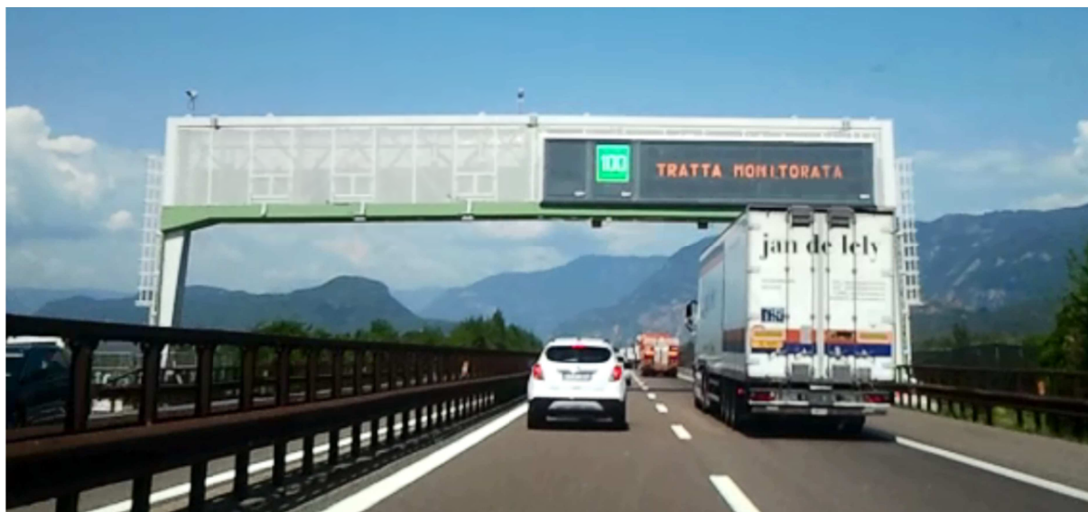
Figura 4: Messaggio esposto sul PMV a cavalletto di ingresso al tratto sperimentale BLEC-AQ durante una delle sessioni di test.
